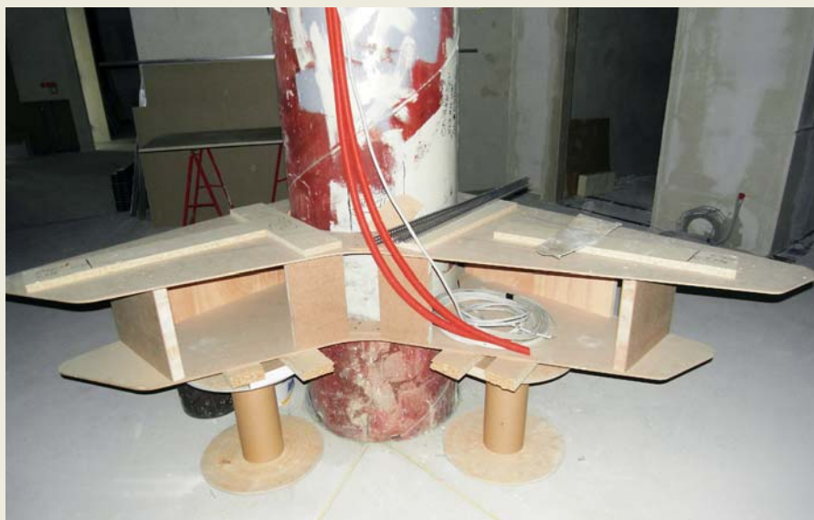
Maßnahmen. Bevor die Teile für die Stützenverkleidung in der Werkstatt angefertigt wurden, wurde vor Ort exakt Maß genommen. Mit Hilfe der so erarbeiteten Schablonen wurde in der Werkstatt gefertigt.
