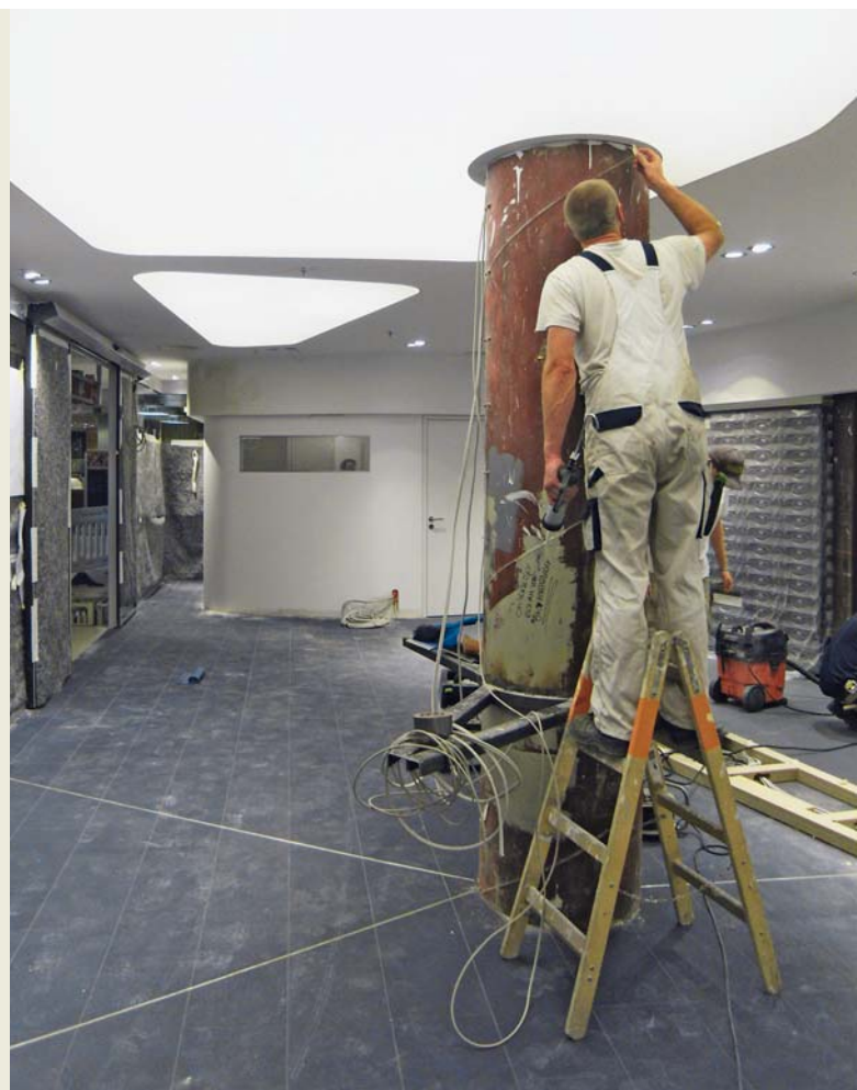
Spanndeckenmontage 2. Aufgrund des geringen Eigengewichts der verwendeten Lichtfolie von nur 240 Gramm pro m 2 war keine aufwendige Unterkonstruktion für die gespannte Lichtdecke nötig.
