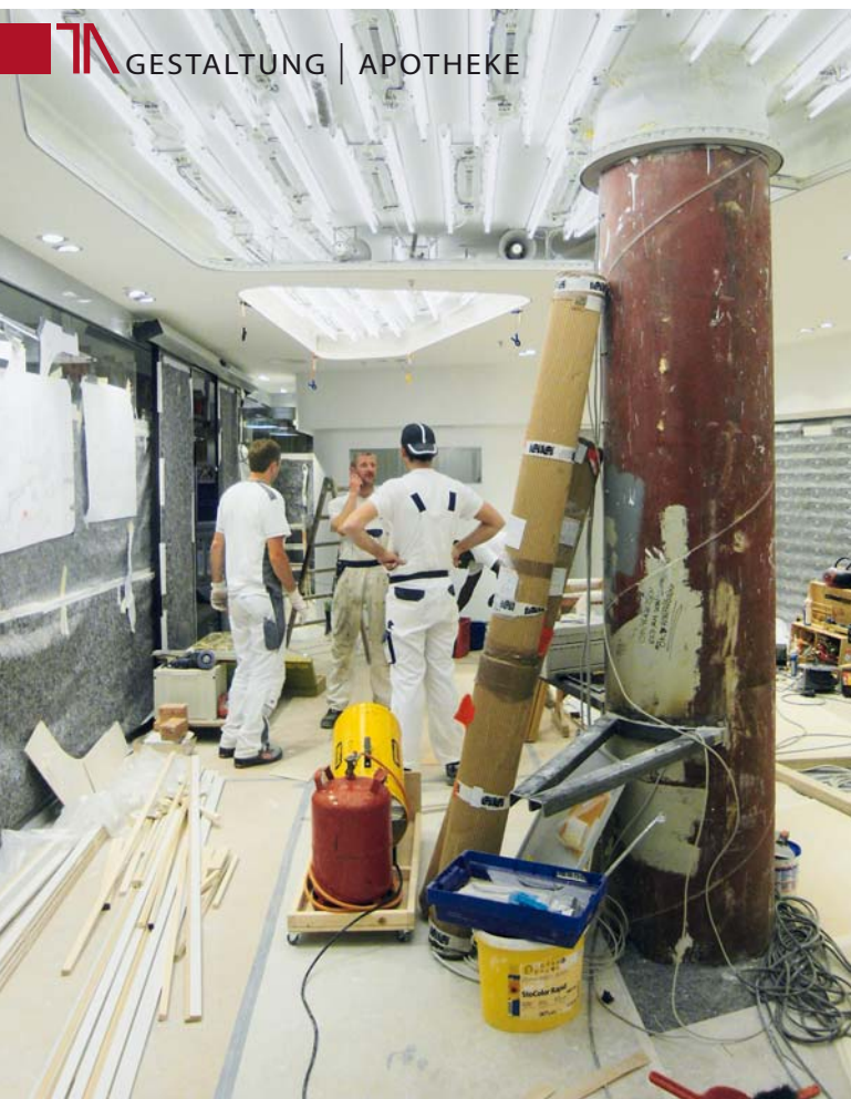
Spanndeckenmontage 1. Stufenlos dimmbare T5-Leuchtstoffröhren hinter der transluzenten Diffusorfolie erwecken den angenehmen Anschein von Tageslichteinfall. Die Lichtdecke montiert hat die Drytec Innenausbau aus Seelze.
