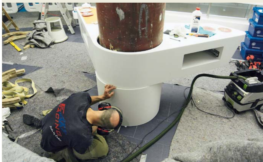
Endmontage. Die zwei auskragenden Elemente können als Beratungstisch sowie als weitere Kassenstelle genutzt werden. In das Element sind alle nötigen Netzwerkanlüsse integriert.
