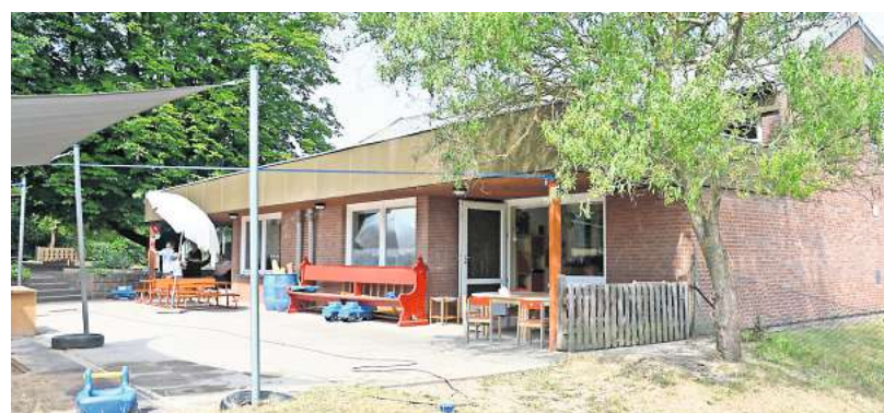
An der Krausenstraße in Mellendorf sollen die Kleinen im Garten eine vorläufige Bleibe finden. FOTO: ANDREA HESSE (KIRCHENKREIS)
